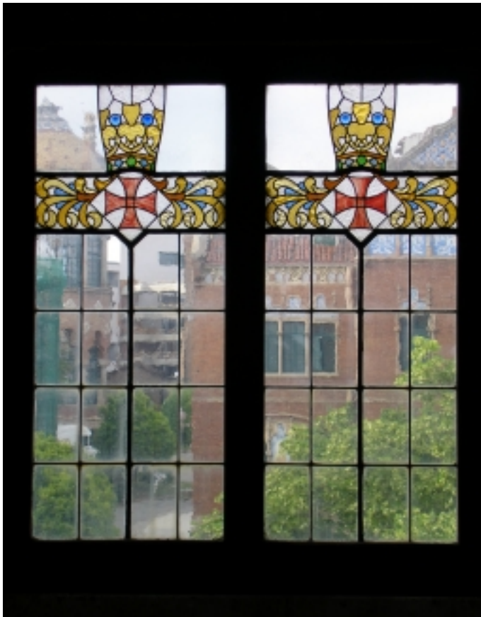
Figura 3. Vitrall de l'Hospital de la Santa Creu i Sant Pau. Pavelló d'Administració, 1911. (Fotografia: Sílvia Cañellas)
