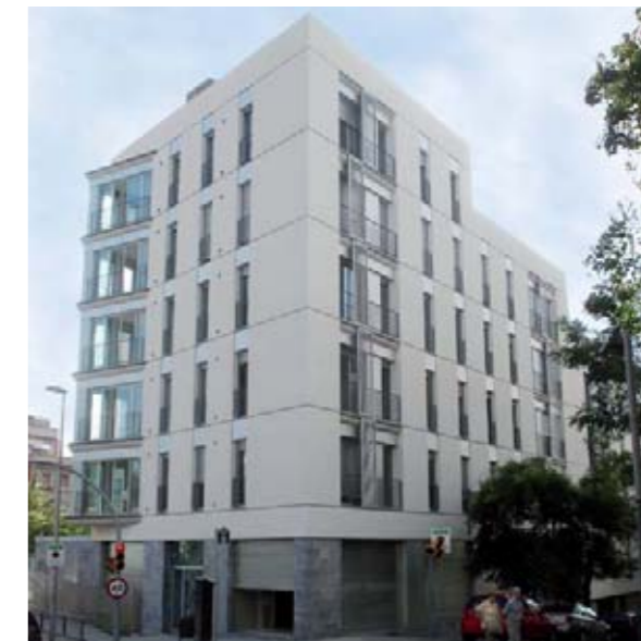
c/ Encuny, 7 114 habitatges dotacionals Proviure
