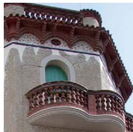
c/ Degà Bahí, 44 Rehabilitació de façana
