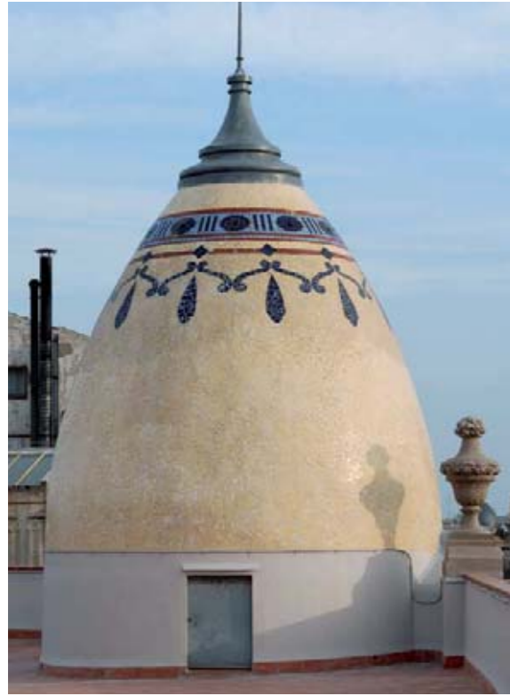
1. Via Laietana, 46 Rehabilitació de terrat i cúpula
