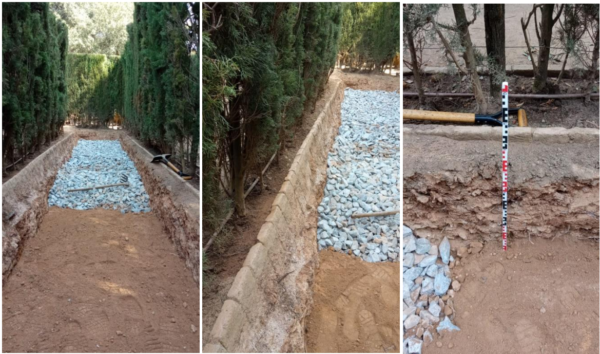
13. Imatges de l'execució dels paviments drenants
