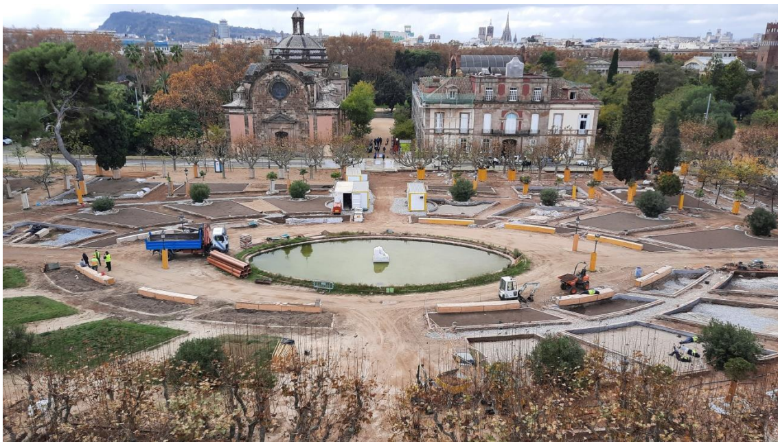
21. Execució dels treballs febrer 2021. Foto – Jana Miró
