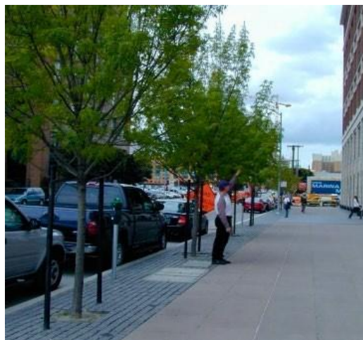
Rasa contínua amb sòl estructural i paviment permeable, SUDS. Font imatge: Urban Horticulture Institute Cornell University
