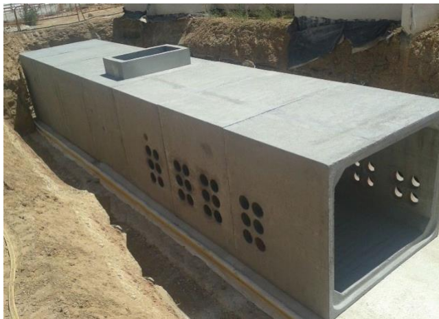
Galeria de serveis prefabricada
