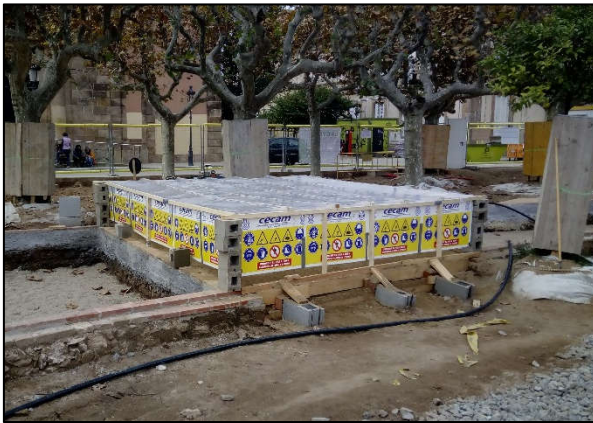
FIG. 9: Vista frontal de l'estructura muntada
