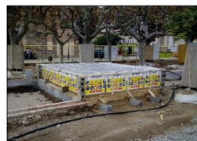
FIG. 9: Vista frontal de l'estructura muntada
