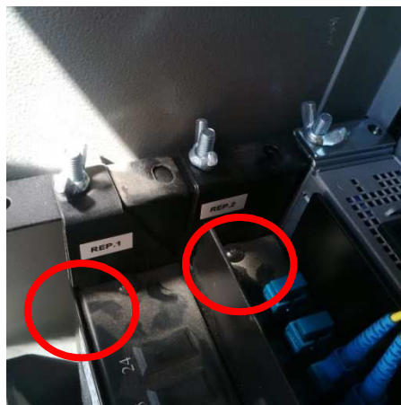
Il·lustració 6. Exemple retolació Repartidors de fibra
