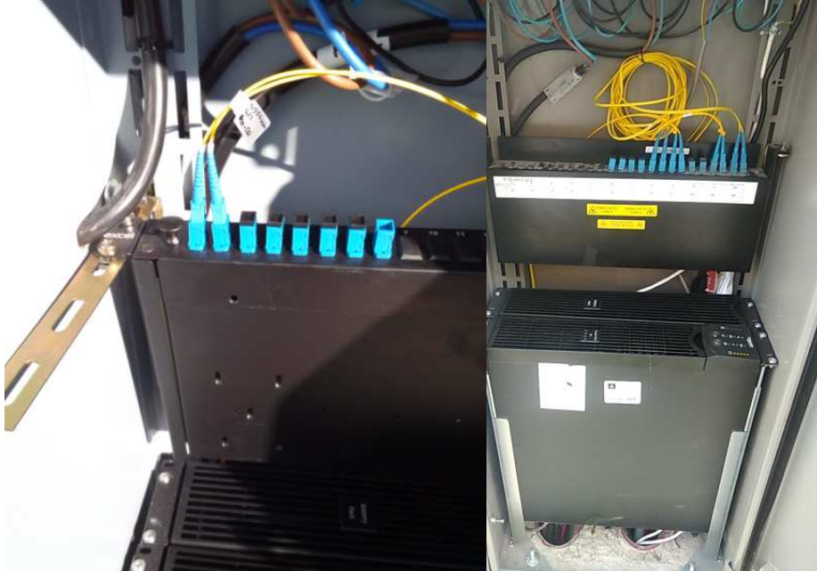
Il·lustració 3. Exemple instal·lació vertical
