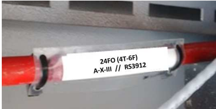
Il·lustració 7. Exemple retolació màniga de fibra
