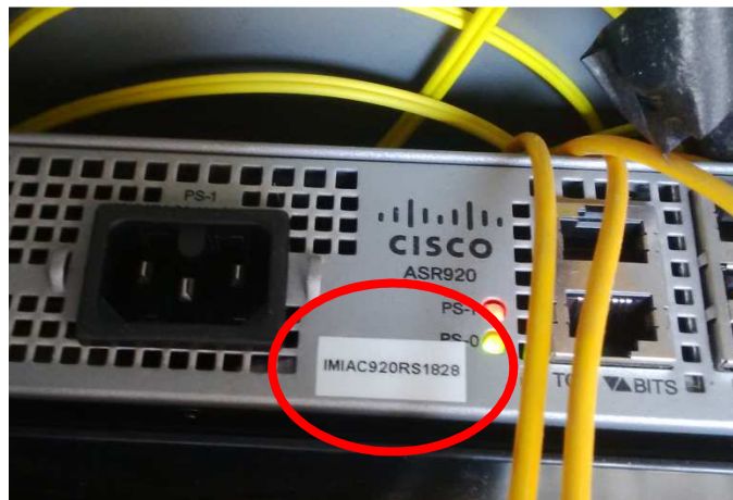
Il·lustració 5. Exemple retolació equip de xarxa
