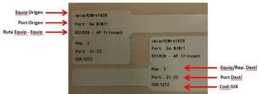
Il·lustració 8. Exemple rotolació fuetons de fibra
