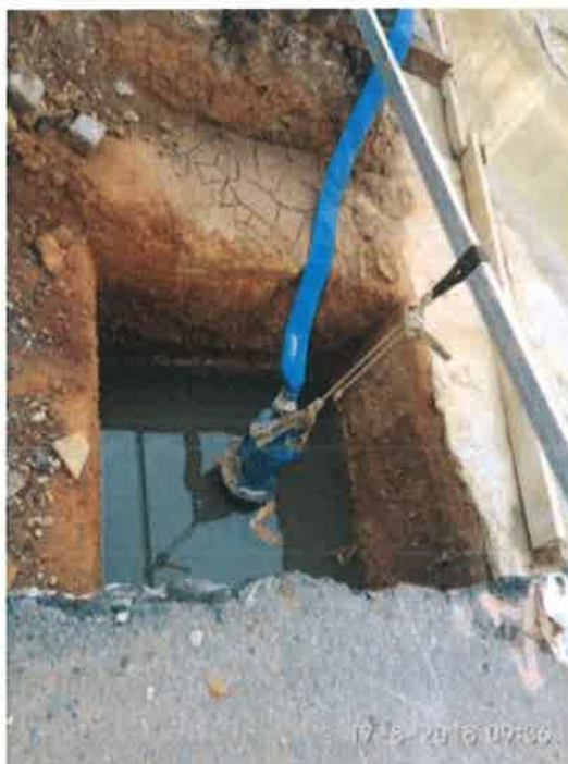
Foto 41 –Pozo de recogida de resurgencia.
