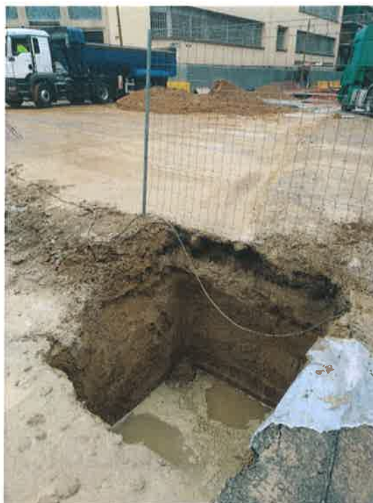
Foto 47 – Excavación de un segundo pozo de resurgencia.
