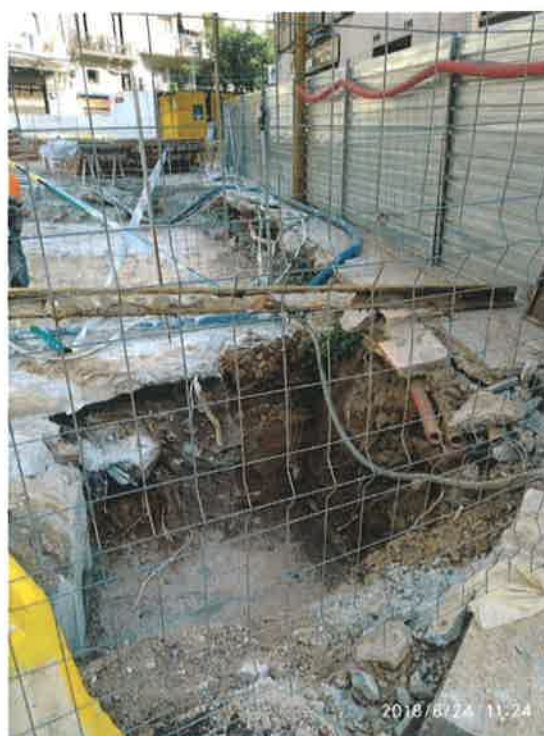
Foto 46 – Excavación de un segundo pozo de resurgencia.
