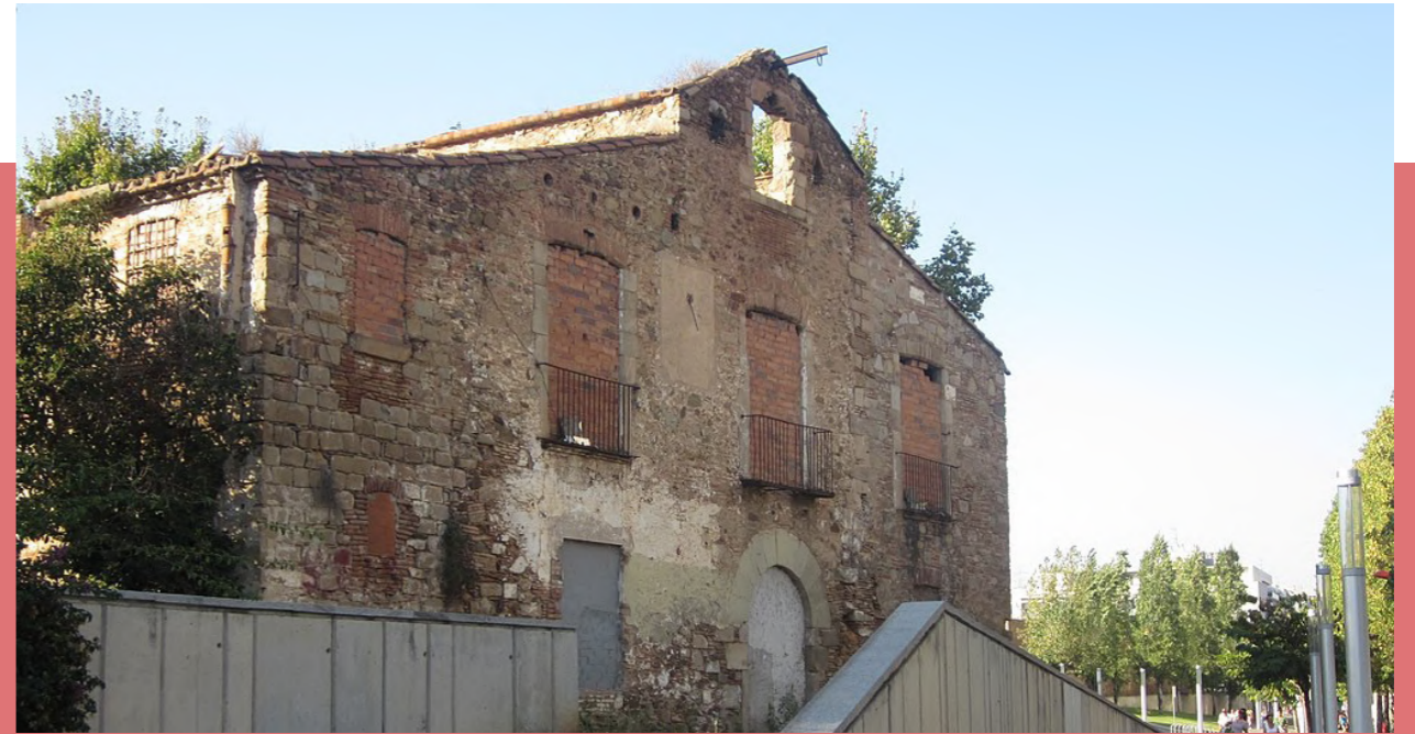
Masia de Can Valent, vista des de l'avinguda de Rio de Janeiro. Districte de Nou Barris, Barcelona. 2021 Autoria: By Electro07 - Own work, CC BY 3.0
