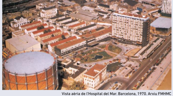
Vista aèria de l'Hospital del Mar. Barcelona, 1970. Arxius FMHMC
