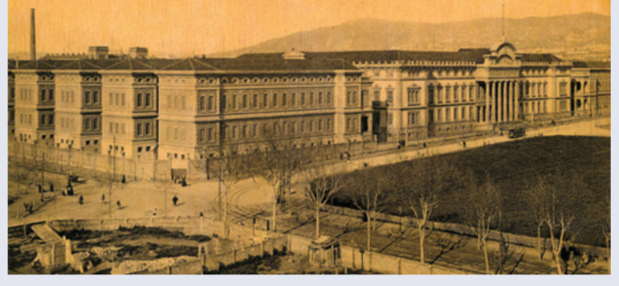
Façanes de l'Hospital Clínic i Provincial de Barcelona i de la Facultat de Medicina de la Universitat de Barcelona, xamfrà Casanova i Provença, amb vista a la línia de tramvia. Barcelona, dècada de 1920. Arxius FMHMC (Fons Carles Hervas)
