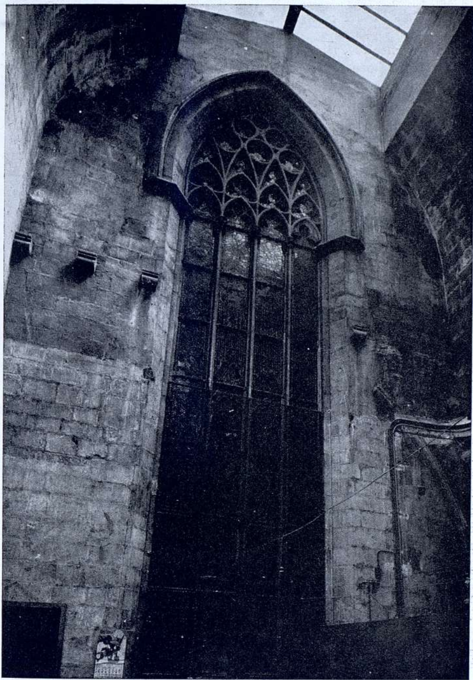
Gran sala, con cubierta de cañón apuntado, sobre la sacristía. Para que el primer ventanal de la girola, de época posterior, no quedase inútil, hubo que cortar la bóveda
