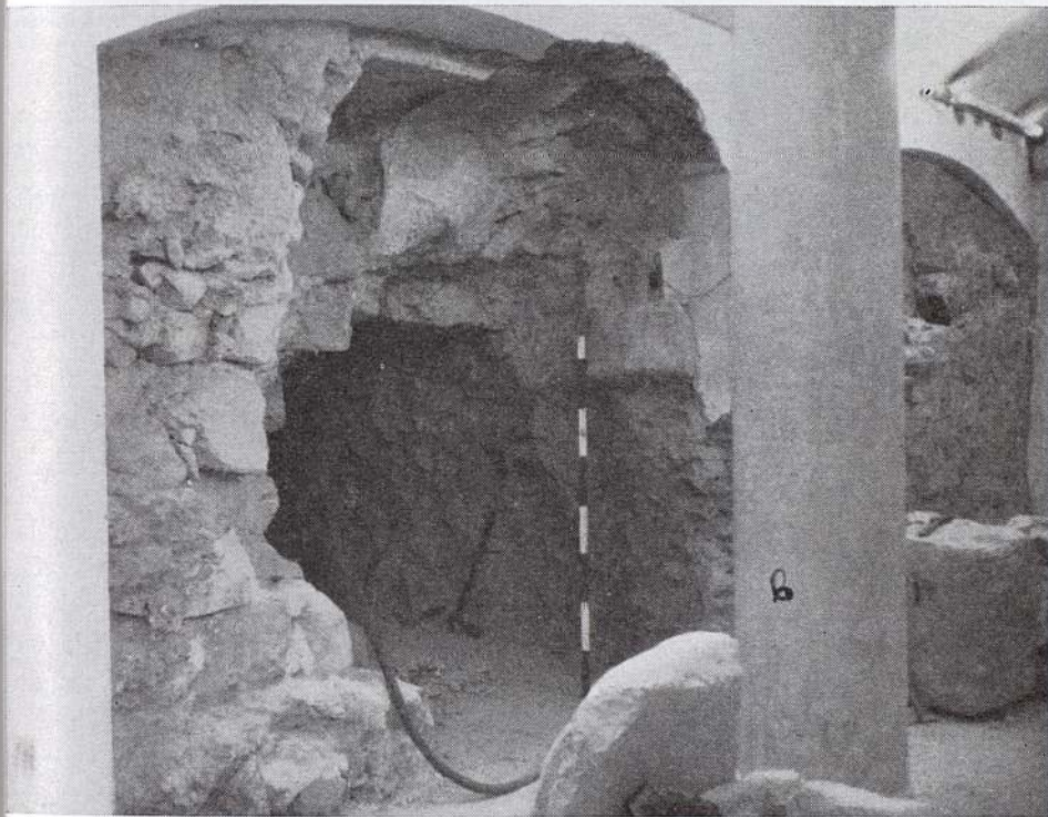
Fig. 2. — Boquete abierto en los cimientos de la Catedral desde el subsuelo de la calle Condes de Barcelona. b) Columna que separa la nave central de la basílica de la nave de la Epístola
