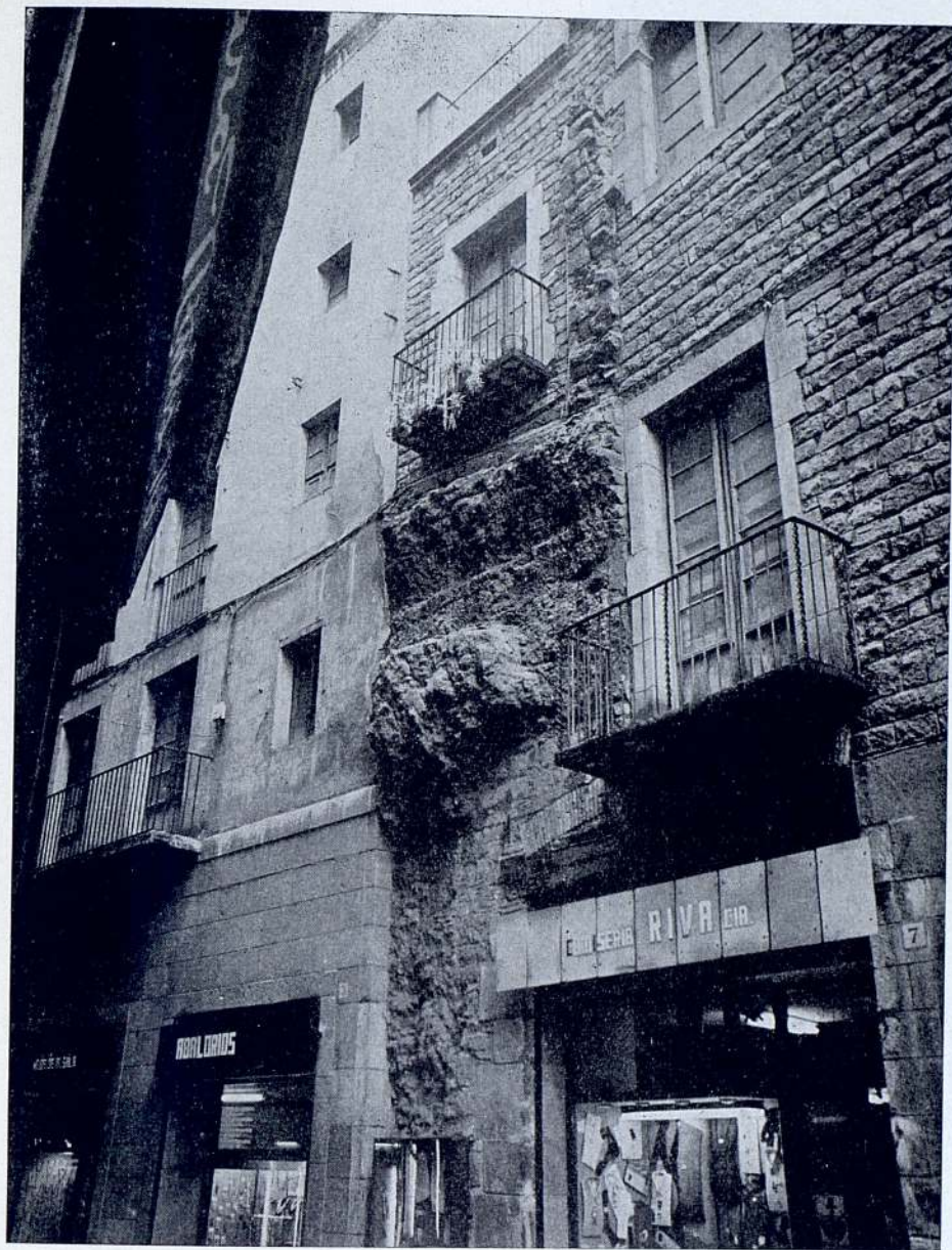
Fig. 27. El arranque del arco de la puerta del Call, que según Pi y Arimón, era la antigua puerta de la ciudad
