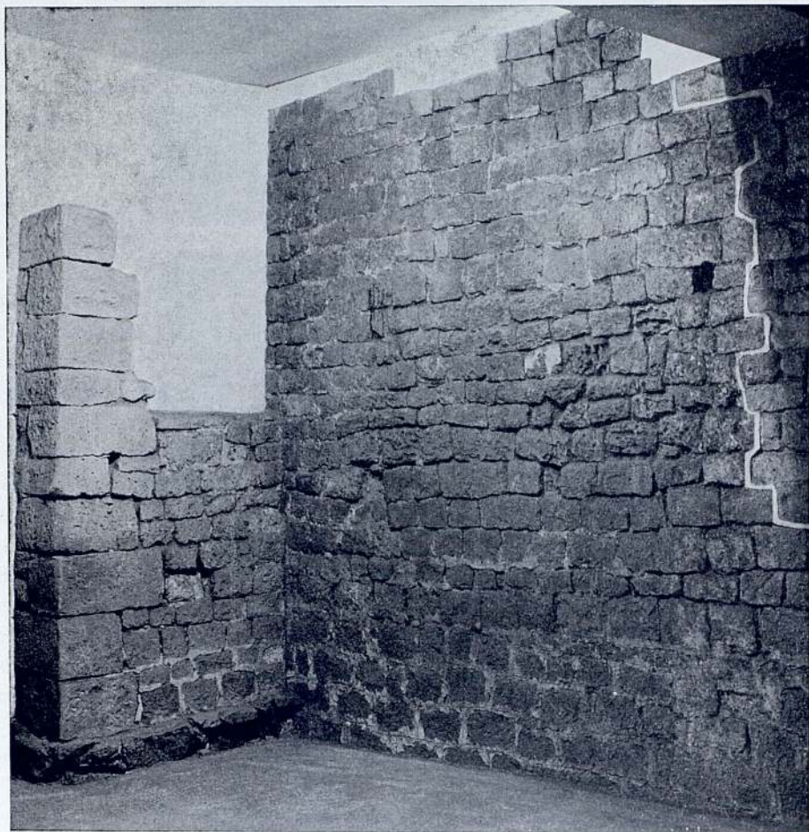
Fig. 11. Fragmento de lienzo de muralla, en su parte interior, en la Casa Padellàs con los pequeños sillares en técnica del siglo I
