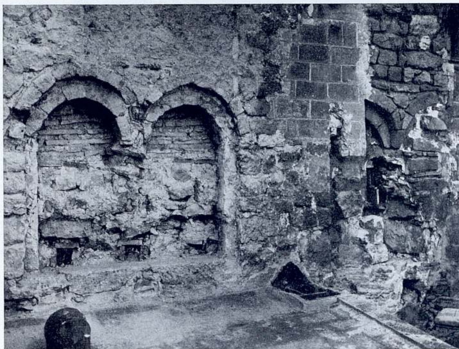
Fig. 17. Finestral de doble arcada, descoberta durant les obres de restauració a la part superior del pany de muralla, de construcció medieval, immediat a la torre restaurada (fot. març 1950)
