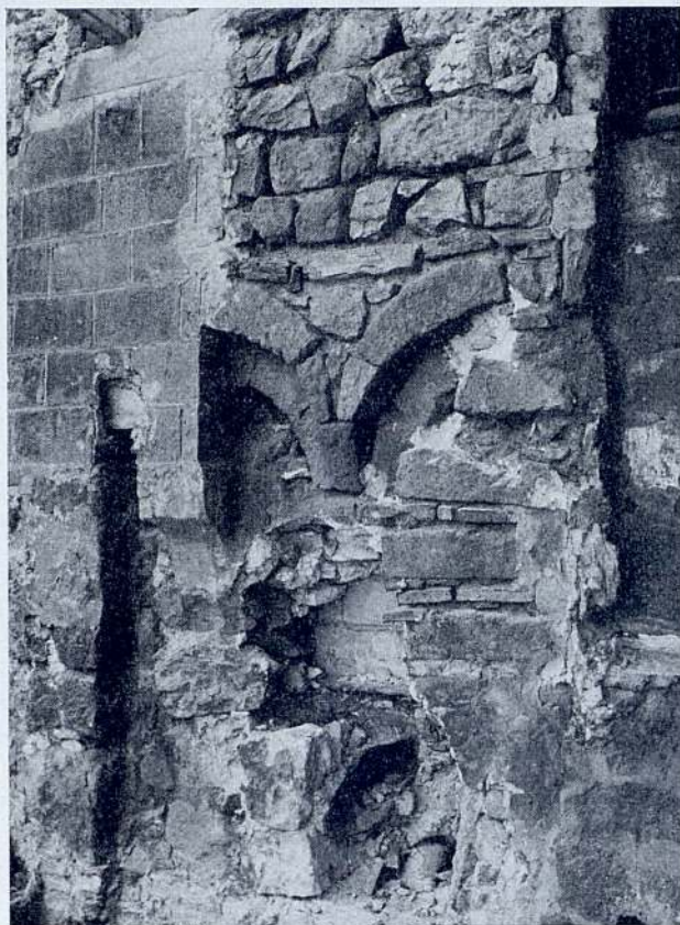
Fig. 15. Restes d'una finestra de doble arc, visible abans de la restauració a la part alta del pany de muralla immediat a la torre poligonal (fot. març 1950) (dibuix de M. Ribas)
