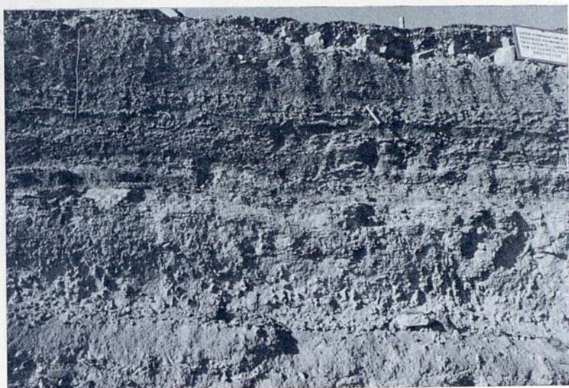
Fig. 2. Corte en una obra
