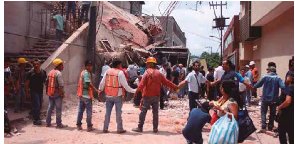
Daños causados en México por el terremoto de septiembre de 2017
