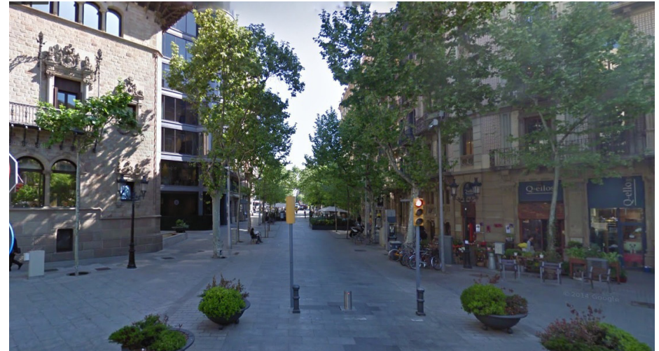
Carrer de Còrsega amb Passeig de Gràcia, exemple de configuració d'un carrer interior de superilla amb plataforma única dins del teixit urbà de l'Eixample. Font: Google Maps
