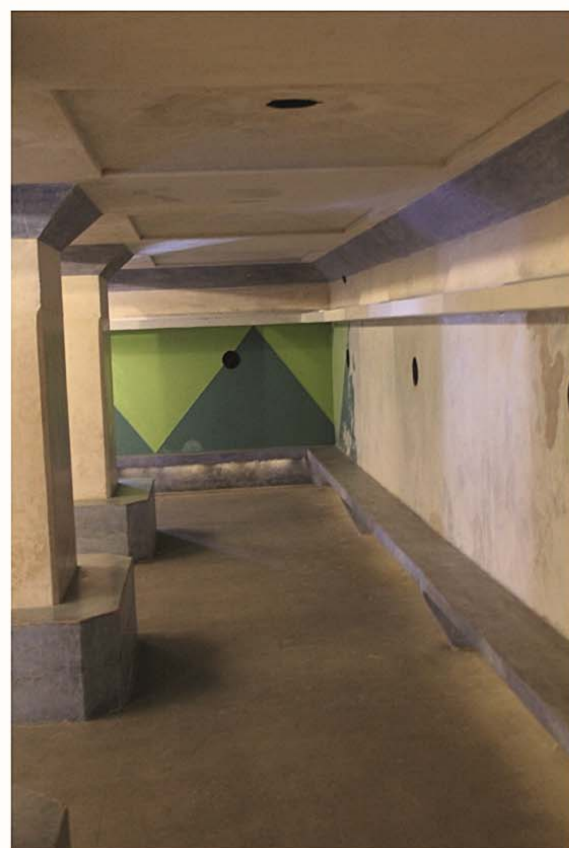
Refugi del carrer Serrans, sostre adintelat, Refugi de districte (1937), carrer Serrans, amb capacitat per 400 persones, amb panels i grafitis d'època
