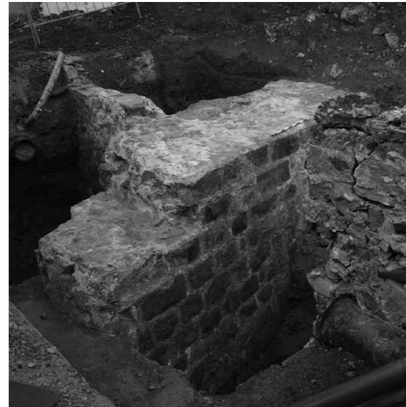
Mur del baluard de Sant Antoni, carrer Comte d'Urgell.
