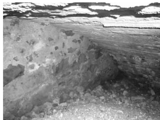
Detall de l'interior d'un dels àmbits localitzats sota l'adarb.
