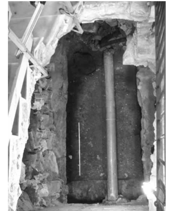
Imatge aèria final de l'excavació del fossat de l'ascensor.
