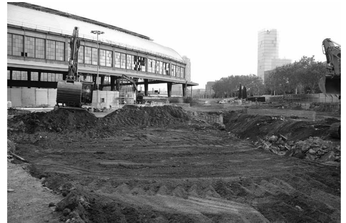
Vista dels treballs de rebaix del terreny al començament de la intervenció.
