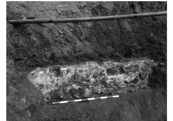
Un dels trams del baluard del Príncep documentat durant la intervenció.
