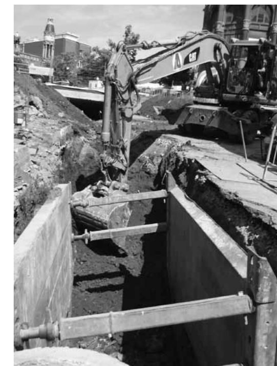
Vista general de l'excavació d'una rasa per a la instal·lació d'un nou sistema de desguàs al recinte històric.
