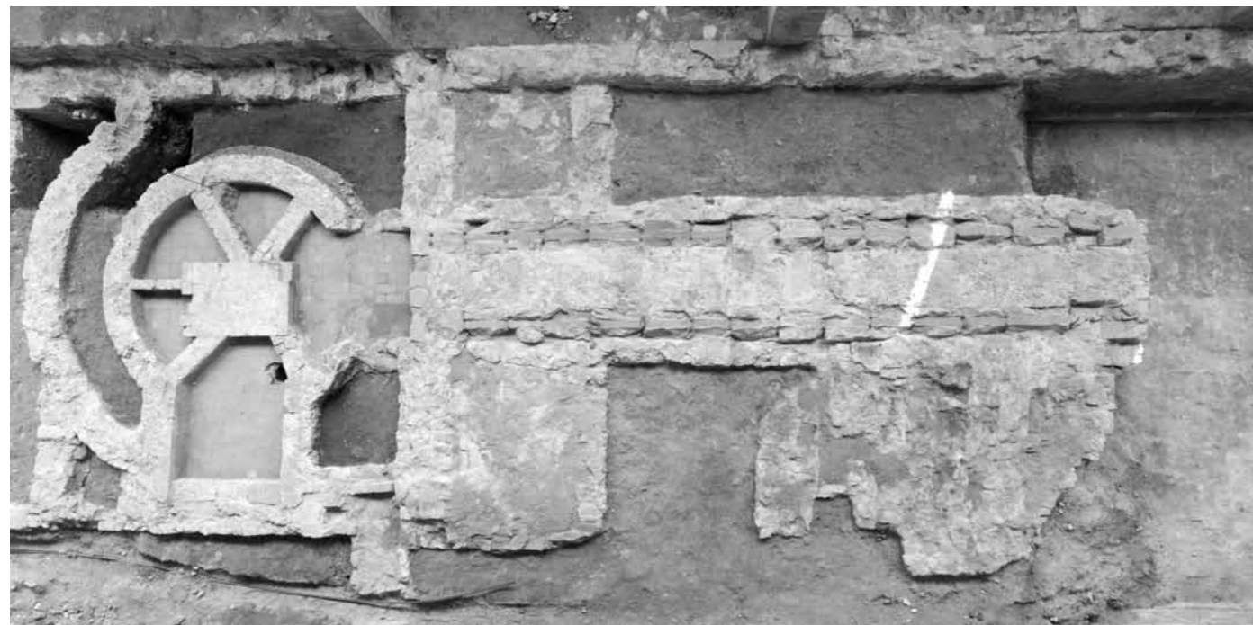
Vista zenital de la fonamentació de la màquina de barrinar canons, 1766. Foto: José Luis Biel, MMB.
