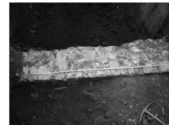
Vista general del mur de contenció.
