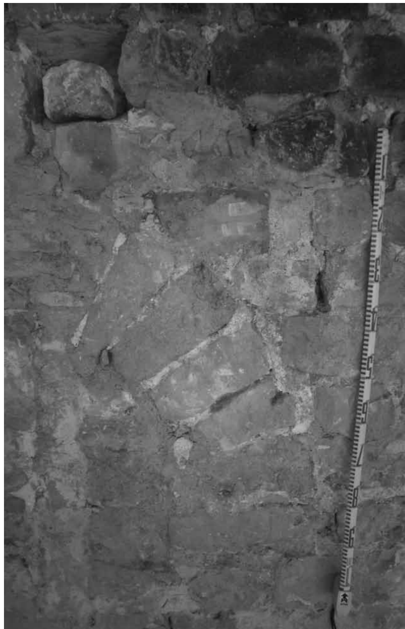
Restes d'una finestra al tercer pis per sobre del massís en opus quadratum .
