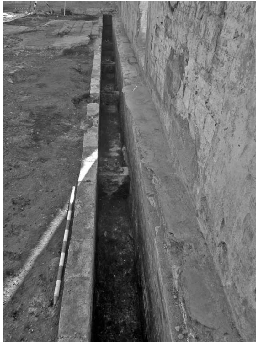
Estructura on es col·locaven els tubs de vapor. Foto: Lourdes Moret.
