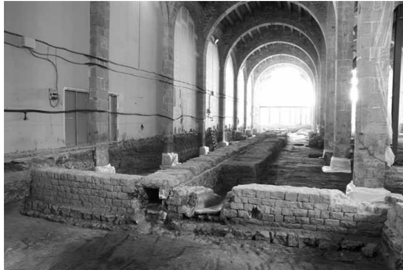
Mur de tancament nord de les drassanes de Pere el Gran.
