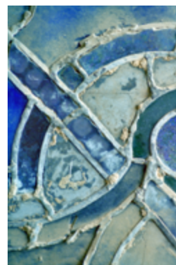
▶ Restes de morter i fractures de vidre. Foto de la cara externa sense llum transmesa.
