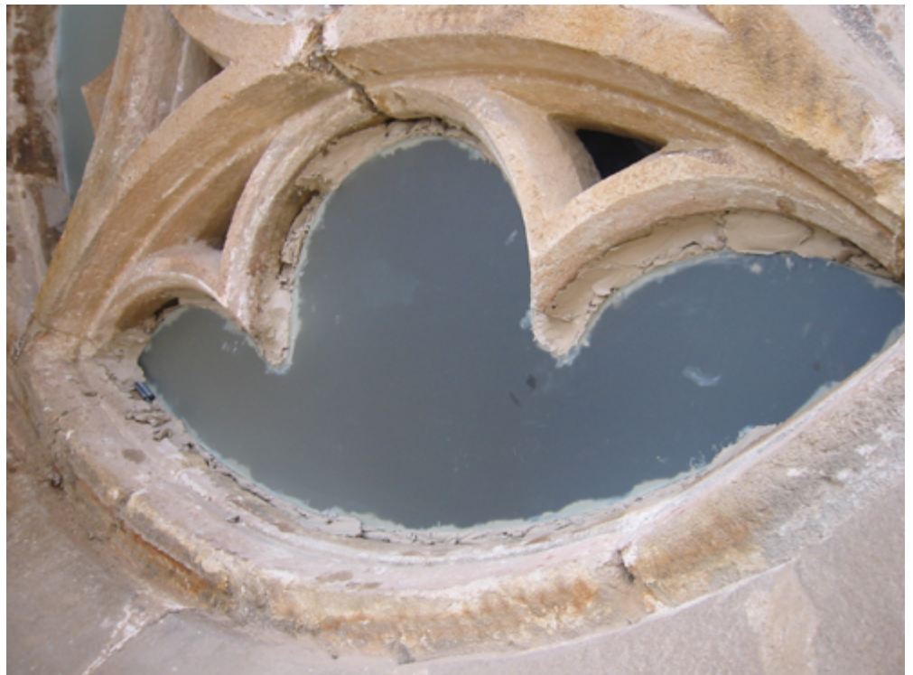
Instal·lació de nous vidres de protecció
