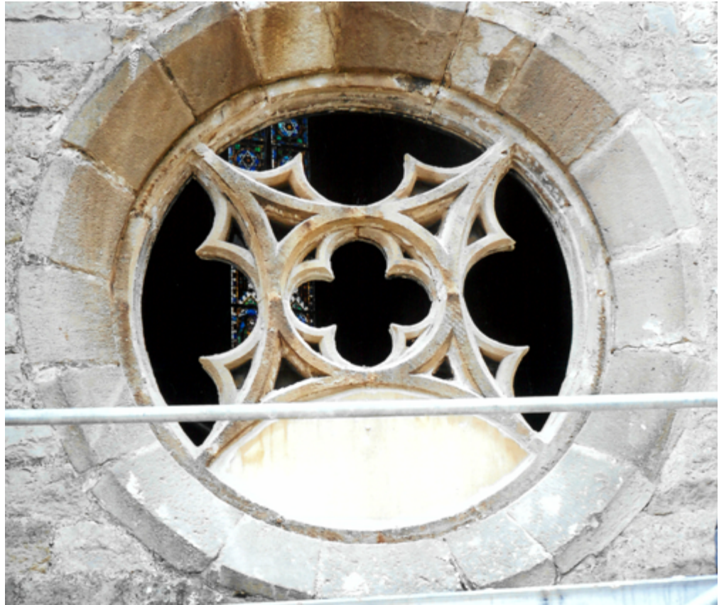
Desmuntatge dels plafons i protecció provisional
