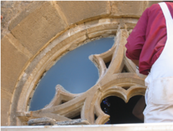
Instal·lació de nous vidres de protecció.
