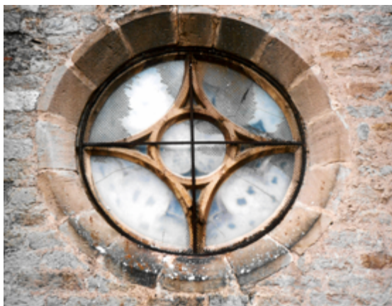
Malles metàl·liques i vidres de protecció en començar la intervenció.
