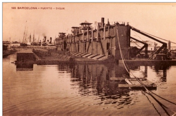
Figura 4. Dique seco y deponente.
