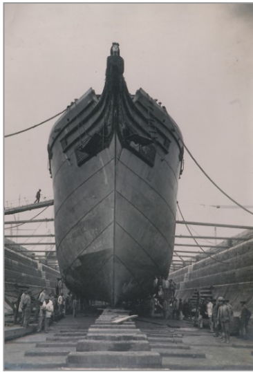
Figuras 2-5. El Elena en reparación.
