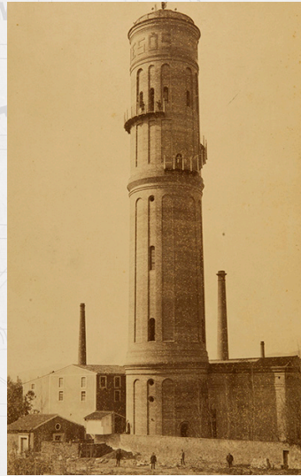
Torre de les Aigües del Besòs de la Companyia d'Aigües de Barcelona. Autor desconegut. 1888. Arxiu Fotogràfic de Barcelona
