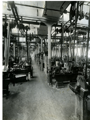
Interior de la Hispano-Suïssa, al barri de la Sagrera. Autoria: Desconegut. 1934. Arxiu fotogràfic de Barcelona.
