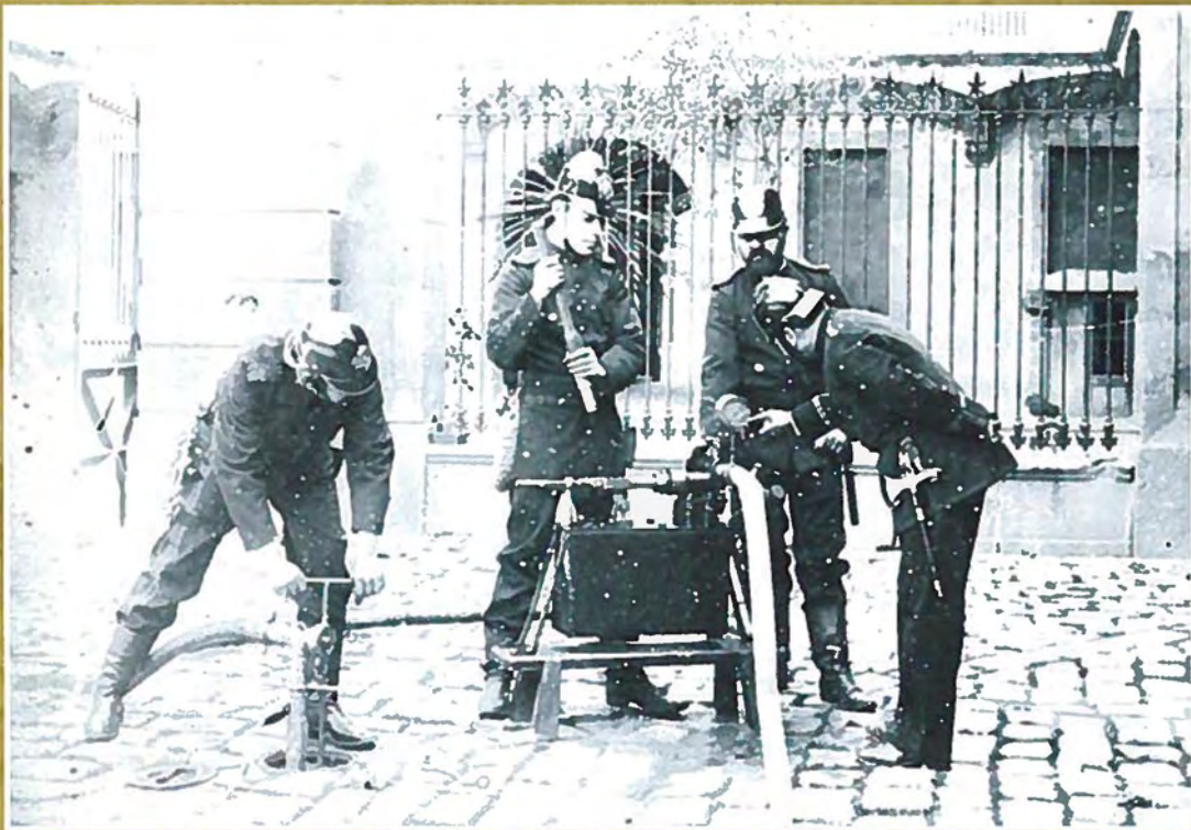
Aparell per comprovar mànegues un cop utilitzades, a principis del segle XX
