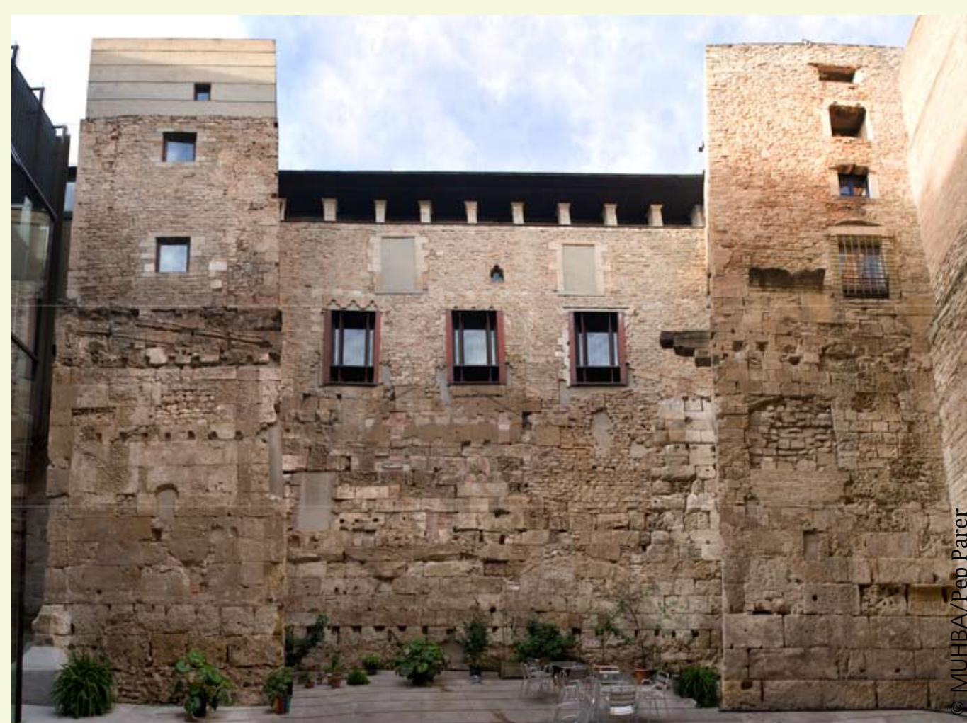
Figura 12. La Casa dels Marc, restaurada, amb la muralla romana a sota.
