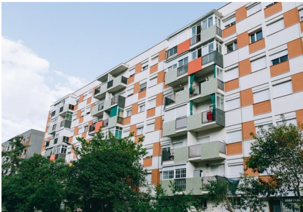
Edifici rehabilitat a c/Vallcivera, Ciutat Meridiana
