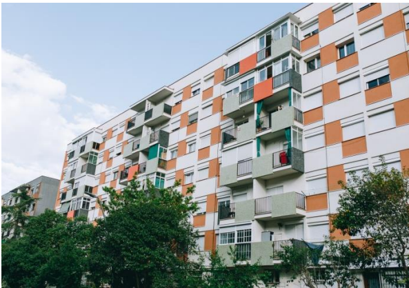
Edifici rehabilitat a c/Vallcivera, Ciutat Meridiana
