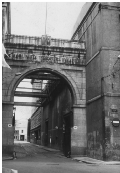
1950-70 AFLACAT ARC MAQUINISTA agparquitectes.com
