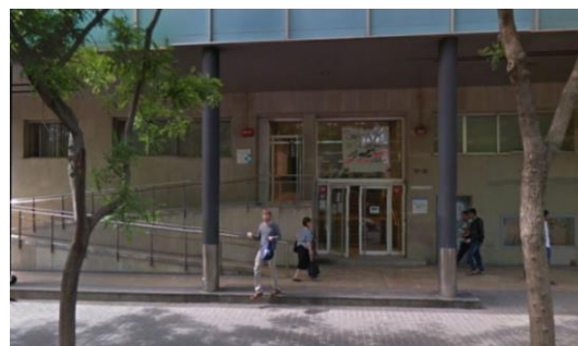
CAP Drassanes Propera instal·lació de mòdul
