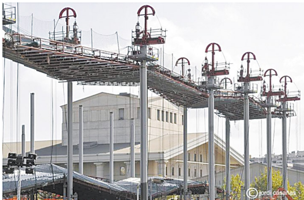
Procés d'aixecament de la coberta del nou mercat Encants Barcelona
