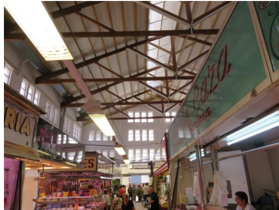
Obres a la coberta del Mercat de Tres Torres
