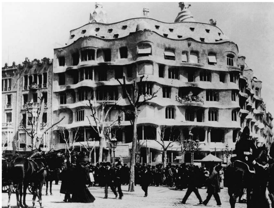
Casa propietat de Roser Segimón, al passeig de Gràcia, més coneguda per la Pedrera. Arxiu Municipal districte de l'Eixample.
