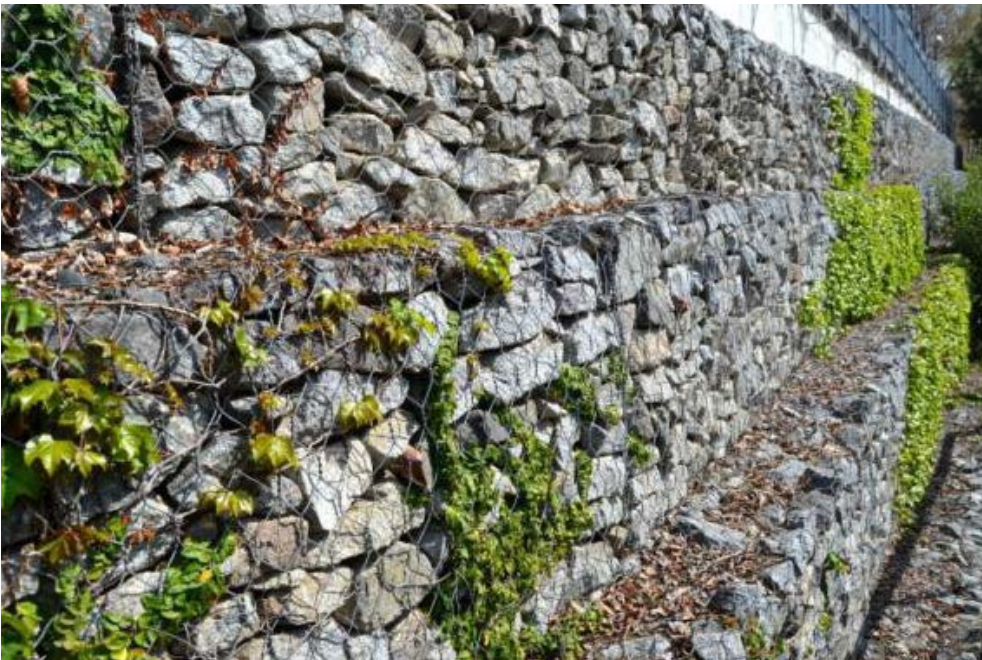
Parc de les Aigües' gabion walls
