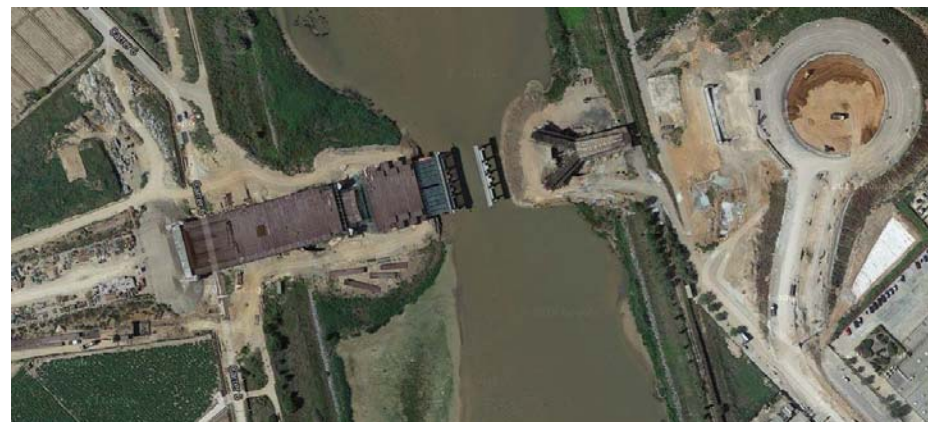
Figura 4: Construcció del nou pont Prat-ZAL. Font: Google maps.
