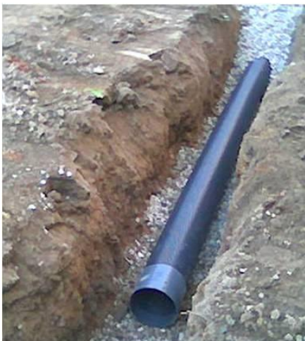
Imatge 5. Construcció de rasa drenant als jardins dels Drets Humans
