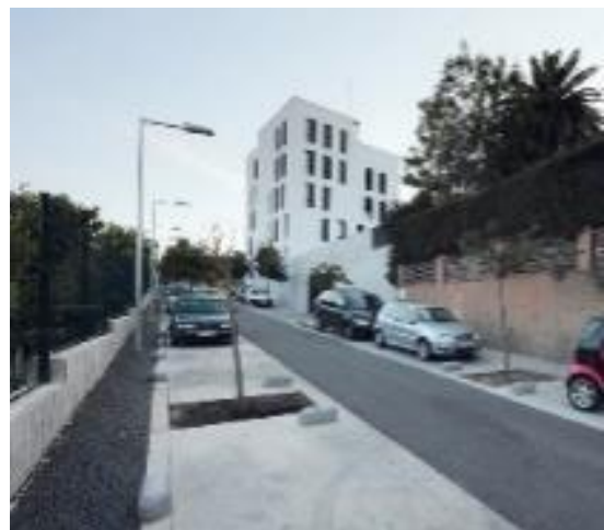
Imatge 6. Rasa drenant a la zona del Torrent de les Monges
