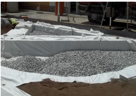
Imatge 15. Construcció de dipòsit de graves a Bon Pastor
