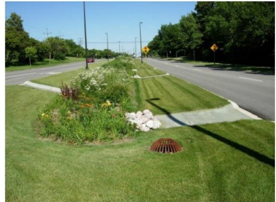
Imatge 8. Franja vegetada amb parterre inundable.
