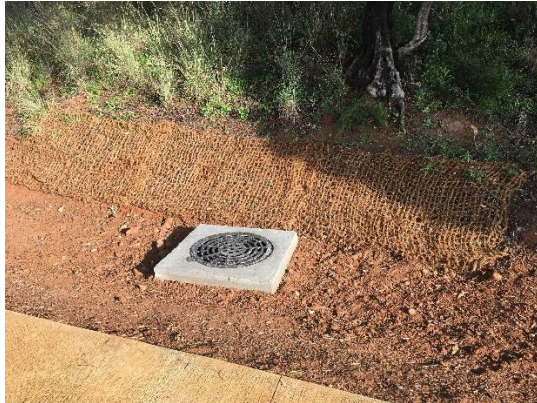
Imatge 21. Cuneta de terres amb fibra de coco al carril bici de l'Av. Diagonal
