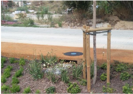
Imatge 29. Sobreeixidor lateral a Ca l'Alíer
