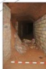
12. Pared d'obra coiguda
