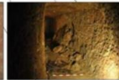
6. Petit desprésament de pared
