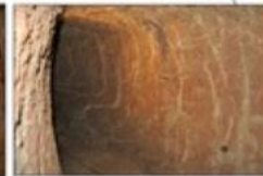
5. Tram excavat al llapis
