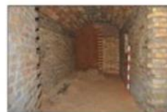
16. Petita galeria construïda
