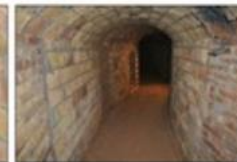
15. Tram construït i fornícula
