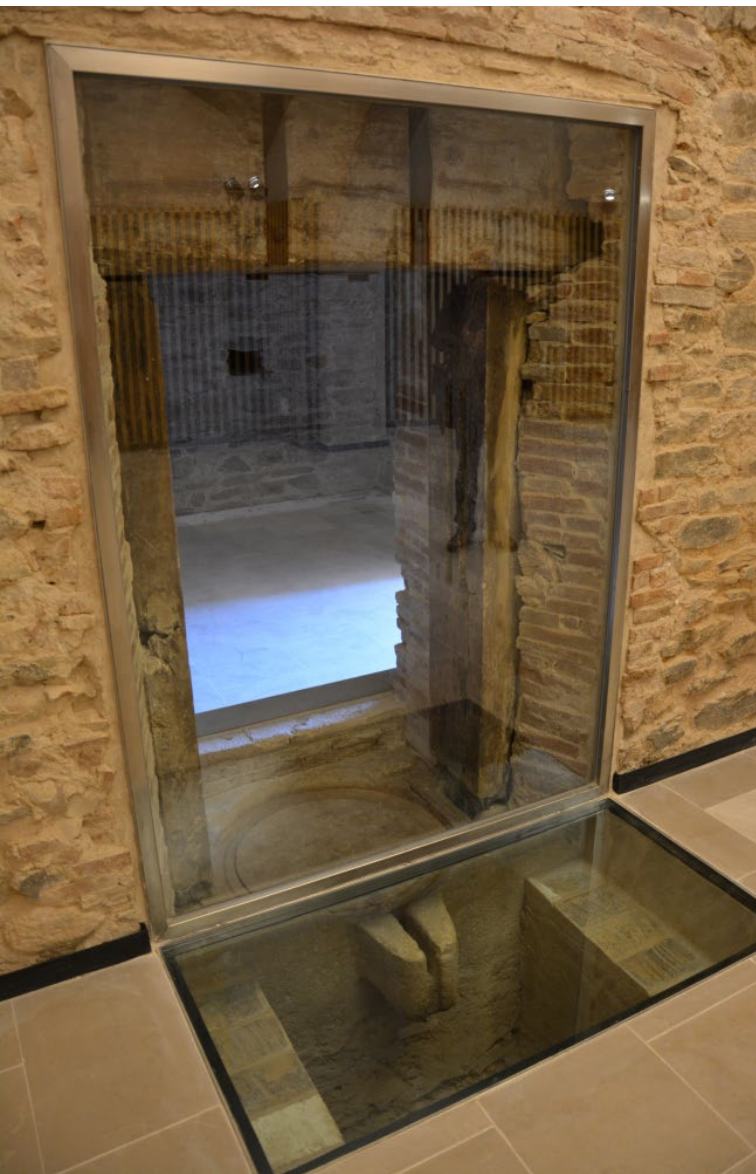
La premsa al parament exterior de la planta baixa després dels treballs de restauració
