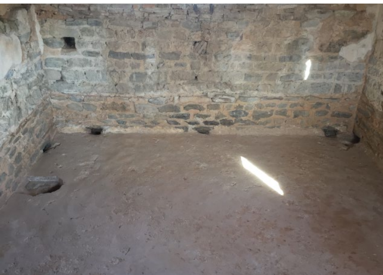
Detall de paviment hidràulic impermeable amb els forats d'evacuació d'aigües pluvials s. XI-XII
