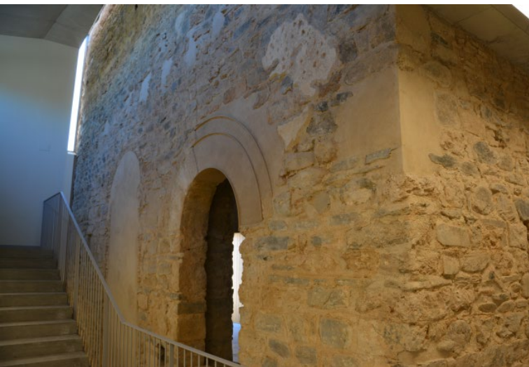
Exterior de la torre i entrada original segle XI. A primer terme es veuen forats de bastides constructives i una espitllera
