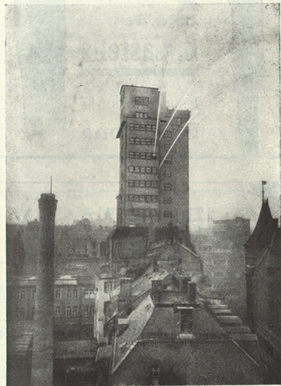
Pruebas de Bombas Magirus en la casa torre del Diario de Stuttgart
