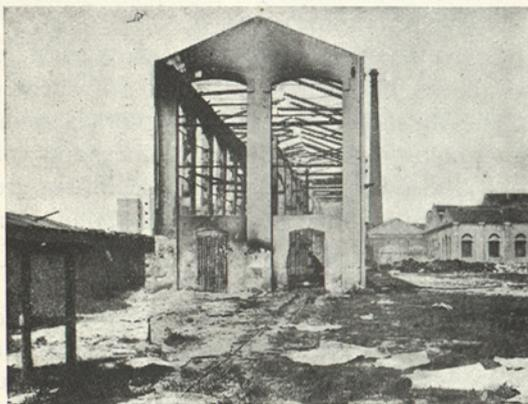
El incendio presentó las características clásicas del caso. Propagación instantánea del fuego, hundimiento rápido de la cubierta y pisos intermedios de madera, los entarimados, estanterías y existencias de cartón, formando una inmensa hoguera que convierte el edificio en horno gigantesco, gracias a la disposición de los muros de fachada en enrejados de ladrillo recuadrados por pilastras.
