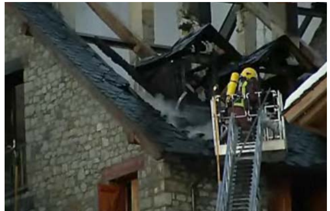
Un bomber inspecciona la teulada d'una de les cases
