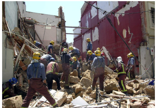
Tasques de desenrunament de l'edifici de Mataró
