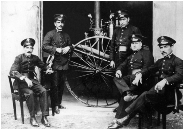
Bombers de Terrassa, l'any 1916, amb la bomba Merrywather
