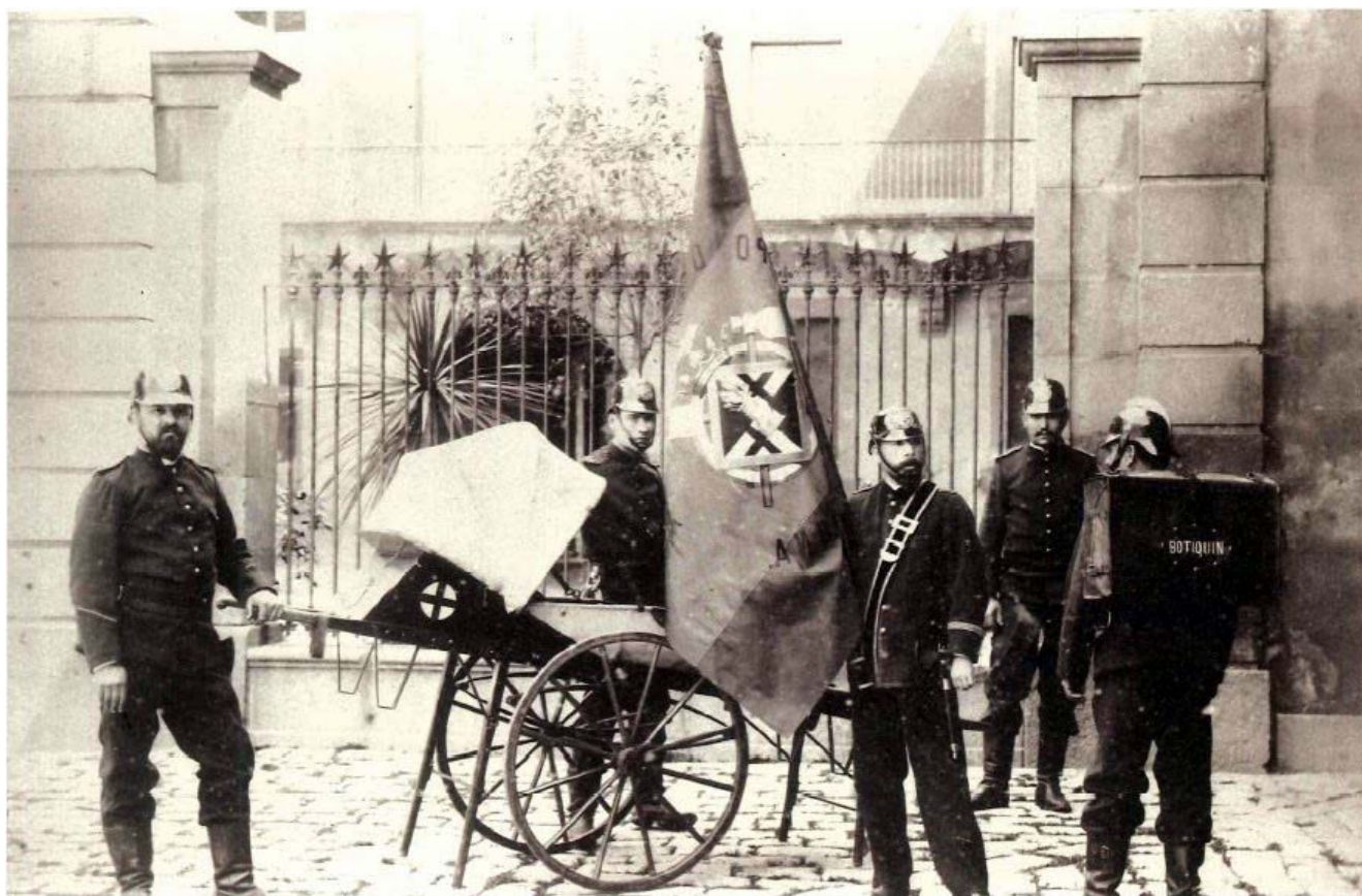
Equip sanitari del Cos de Bombers de Barcelona, l'any 1902. Procedència de la fotografia: Arxiu Bombers de Barcelona
