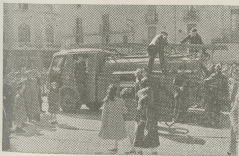
El nuevo bomba-tanque
