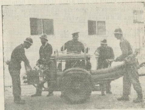
Practicando con una motobomba
