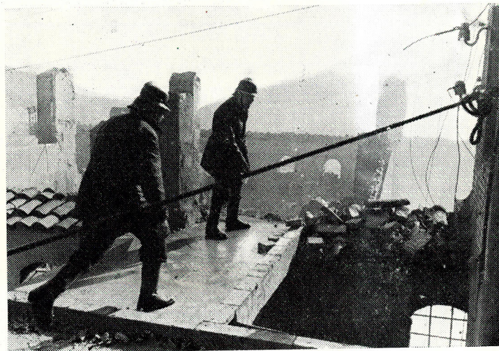
Inspeccionando el incendio.
