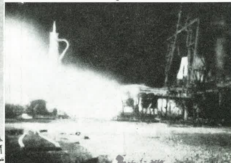
Una erupción de gas se produjo el día 21 de enero en un pozo de gas natural de la fábrica de Lacq (Francia). El gas salió a una presión de 500 atmósferas y se expandió a partir de la salida del pozo, subiendo como un chorro de vapor, con un potente silbido, a una altura de 200 metros. Su olor llegó a sentirse en Dax, a 60 kilómetros. Diez minutos más tarde, el plan de alarma había sido aplicado y un cuarto de hora después se habían evacuado los habitantes en un radio de 1.300 metros y quedaron bloqueadas las carreteras próximas. Gracias a la labor de los especialistas se cohibió el escape en 24 horas. — (Foto de Protection Civile et Industrielle.)
