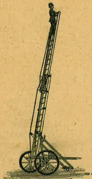
Escaleras Modelo "EDYJOS" hasta 12 metros de altura, para tiro a mano.
