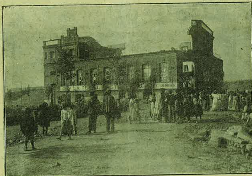
VISTA EXTERIOR DEL EDIFICIO
