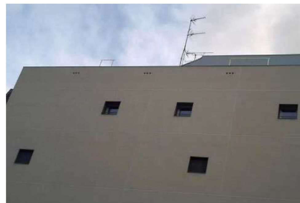
Obres de rehabilitació de la mitgera d'un edifici del carrer de Concepción Arenal. Observeu la presència de forats d'entrada per a falciots a la part superior. Foto: Sergi Garcia
