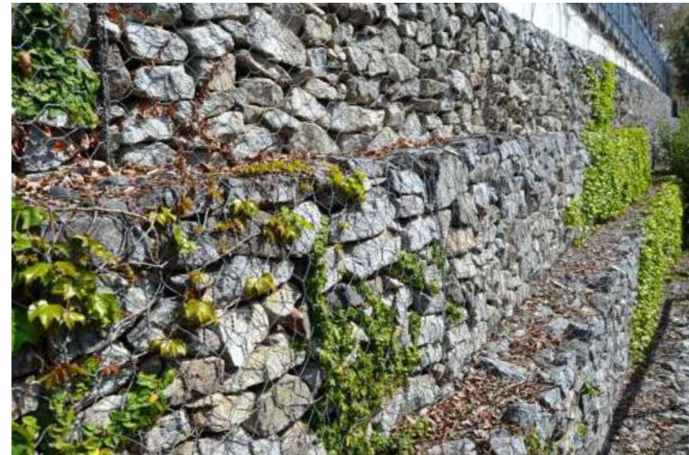
Gabions al Parc de les Aigües
