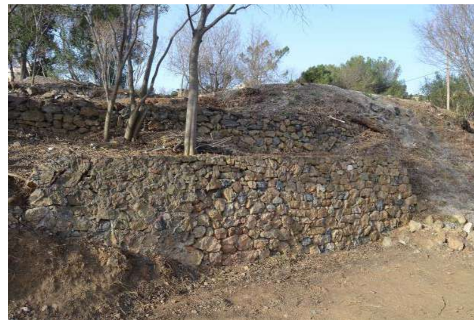
Murs de pedra a Mas Ravetllat
