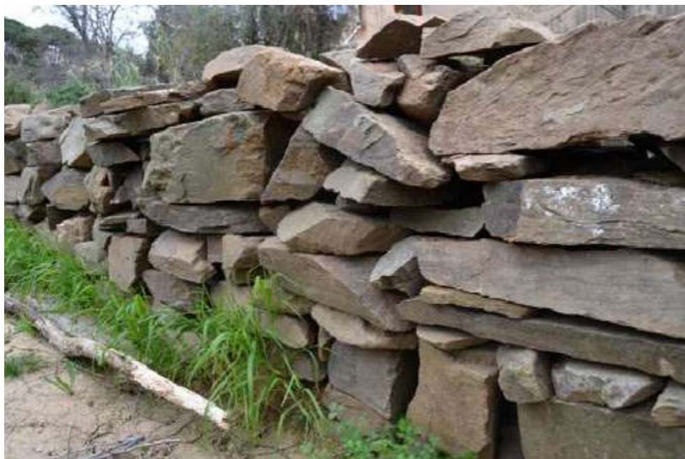
Mur de pedra. Horts de Can Soler
