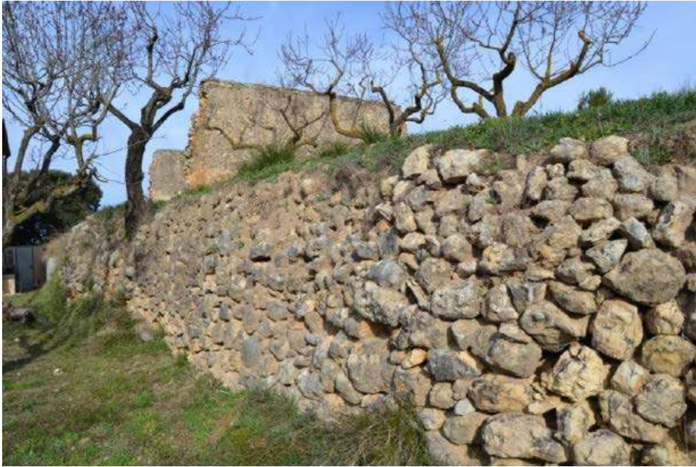
Murs de pedra seca. Les Gunyoles. Província de Barcelona
