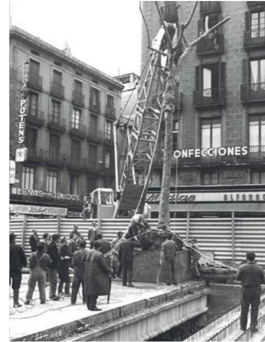
Obres del metro del Liceu. 1968
